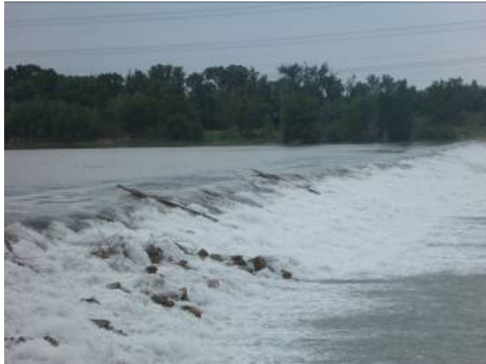
Seuil 68 à Avignon
